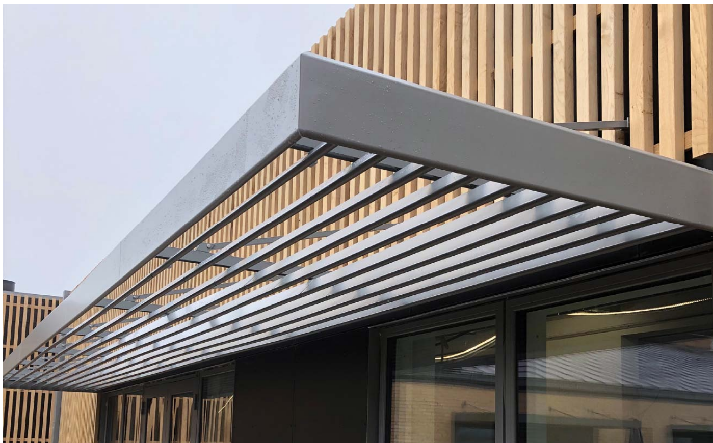
Lamelafskærmning, type JM-FlexiSun monteret vandret med frontprofil og sideprofiler
